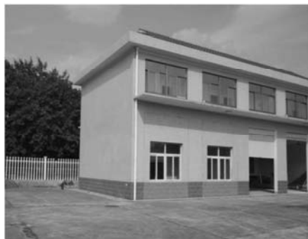
(a) 实验建筑物实景图片
